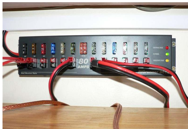
"Power Pole" paneel vir 12V verspreiding
